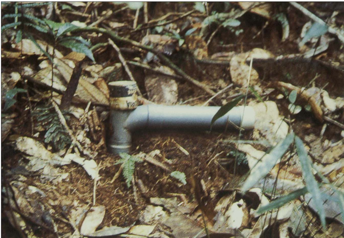
Abb. 7: Messvorrichtung zur Bestimmung des Auftretens von Oberflächenfließen. Aus Vertessy et
