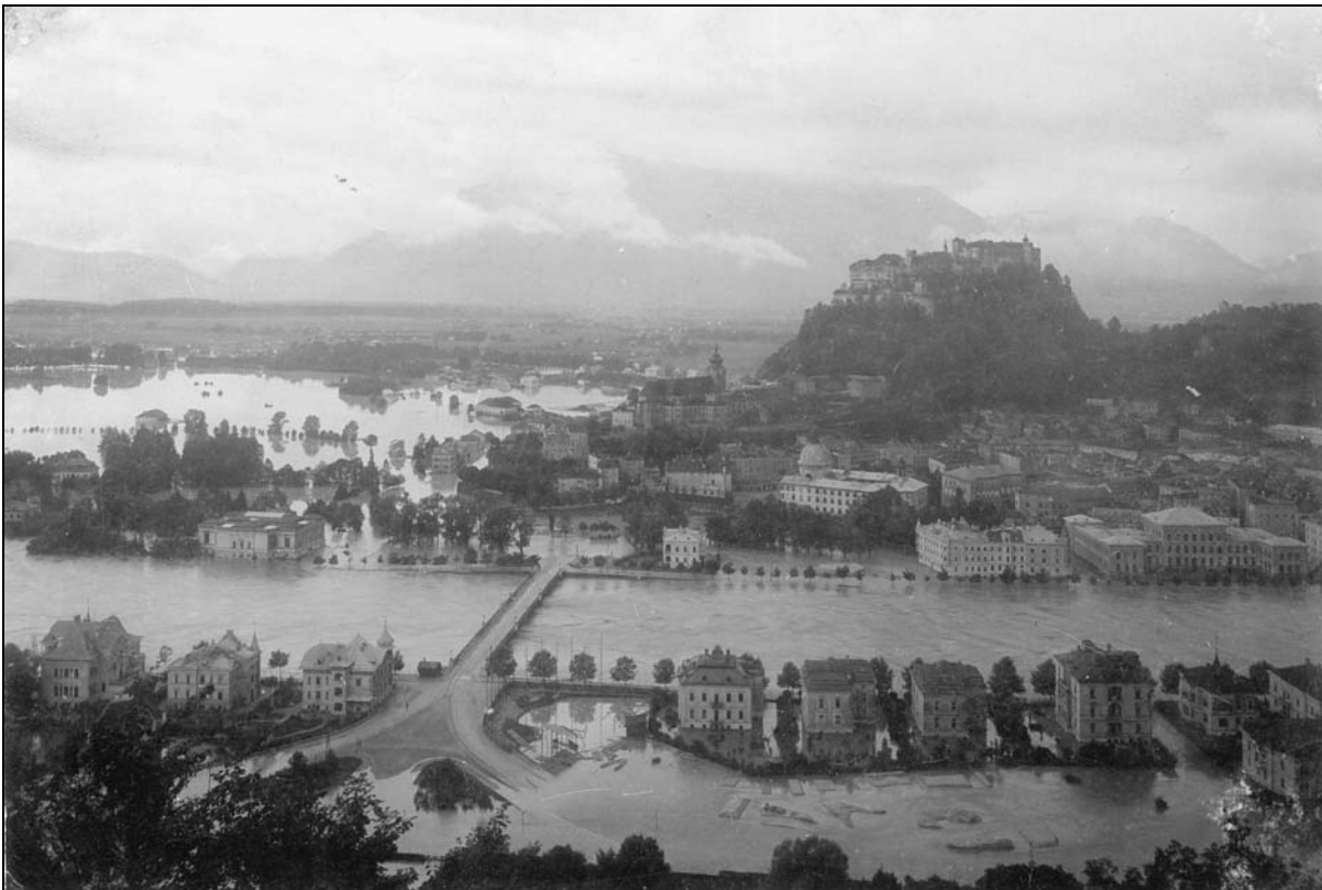
Abb. 1: Hochwasser 14. September 1899, Blick vom Kapuzinerberg auf Salzach und Festung.
